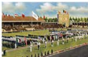
Le premier Tour des Jeux olympiques.
