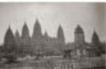
Construction du temple d'Angkor Wat et d'une tour du Bénin (Exposition coloniale de Paris), photographie, 1931.
