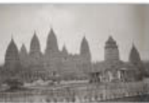
Construction du temple d'Angkor Wat et d'une tour du Bayon (Exposition coloniale de Paris), photographie, 1931.
