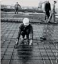
Ouvriers algériens participant à la construction de la Défense, photographie de Gérard Blincoourt, 1972.
