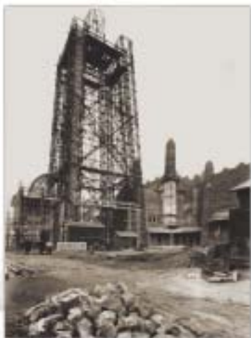
Construction de la tour de soixante mètres du palais de l'AOF pour l'exposition coloniale [Marseille], photographie des Studios Detaillé, 1922.
